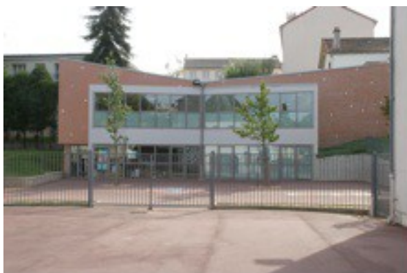
Le bâtiment polyvalent de l'école du Clos Saint-Marcel
